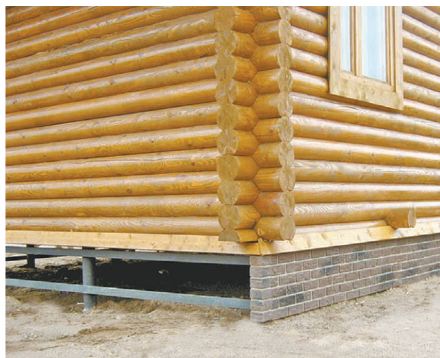
▲ Установленные сваи готовы к нагрузке
