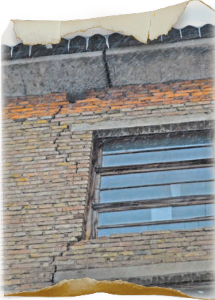
▲ Трещина на стене дома №61
