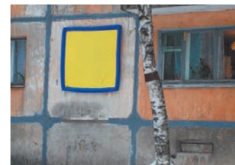
После монтажа окон экран снимают — следов не остается
