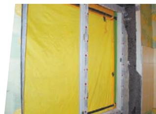
Экран крепится на каркасе, а затем выполняются работы по установке
